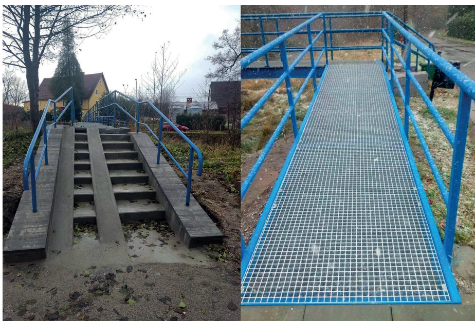
Fot. Zakończono przebudowę schodów i kładki łączącej ul. Wiejską z ul. M. Langiewicza
